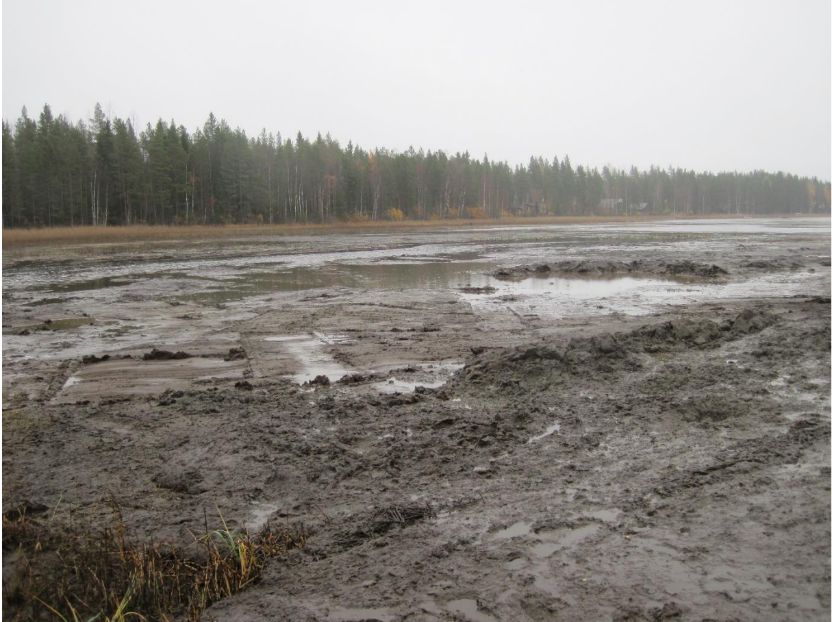
Kuva 2. Kuotesjärven luusuassa laskeutusaltaan ja järven välissä oli pinnanlaskua haittaava matalikko. Matalikkoa aukaistiin kaivinkoneella kaivamalla ojaa noin 30 m pituudelta kuvan ottamista edeltävänä päivänä 16.10.2018.
